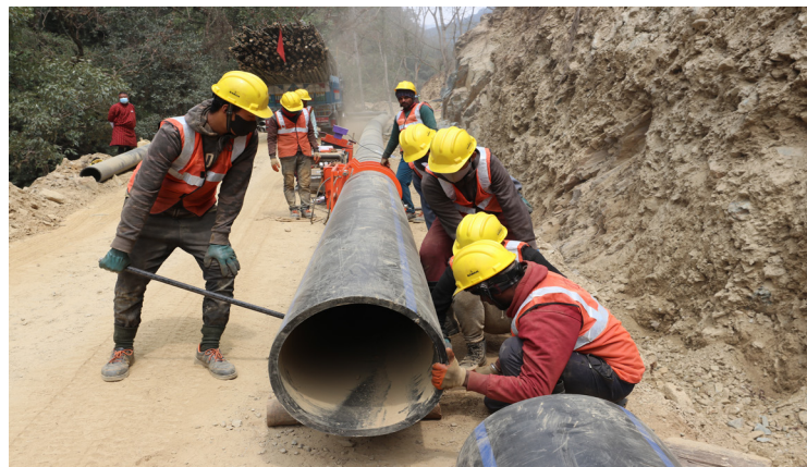
Рабочие в Бутане устанавливают систему принудительного орошения, модернизированную с использованием новых климатоустойчивых технологий, чтобы справиться с дефицитом воды в Пханджиуле. Эта новая система обеспечит орошение более 1300 акров сельскохозяйственных земель, принадлежащих жителям 24 сел.
